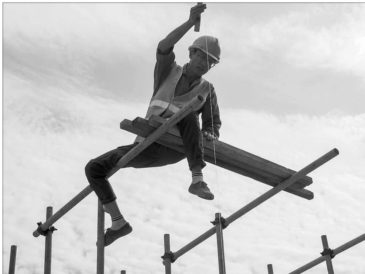
连日来,在东弄畲家田园综合体,工人们加班加点推进项目建设。东弄畲家田园综合体项目是浙江省十个试点工程之一,总投资 3.5 亿元,现处二期施工阶段,投资 5000 万元。(本报记者 李肃人 摄)
